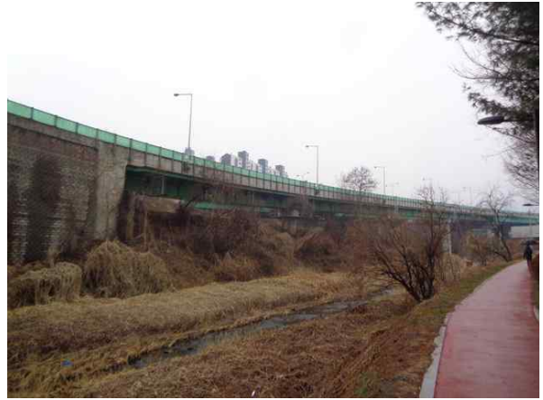
교량 측면 전경
