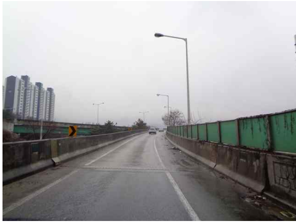
교량 상부 전경
