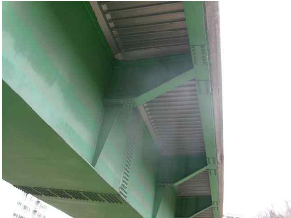
바닥판 하면 및 거더 전경
